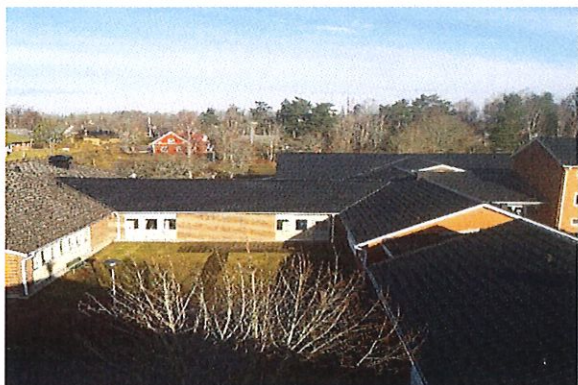
Byte av tak på skolan i Väckelsång
